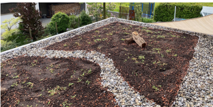
Begrüntes Dach bei der Fam. Pritz
