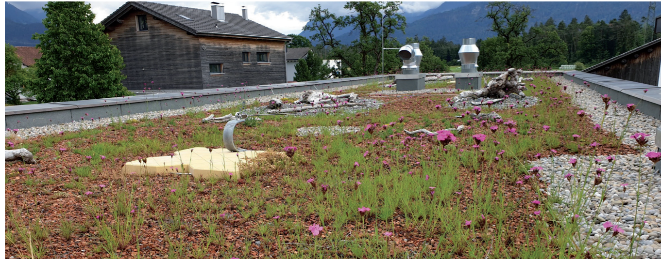
Begrüntes Dach mit Totholz-Elementen auf dem Campus Bludesch
