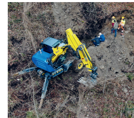
Geotechnische Voruntersuchungen für das Hochwasserschutz-Projekt Montjola-Schwarzbach
