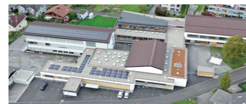
Schon bald soll auf noch freien Dachflächen auf dem Campus Bludesch Sonnenstrom erzeugt werden.
